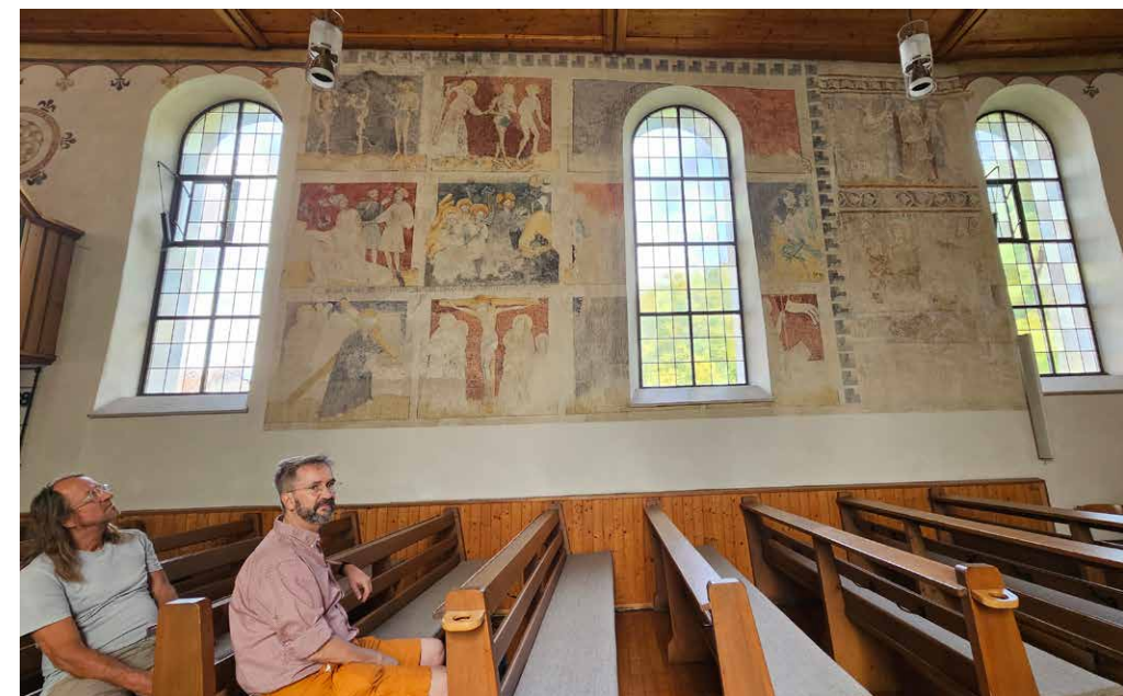
Kirche Gruibingen mit mehreren Schichten alter Bemalung, teilweise zerstört durch Einbau größerer Fenster.
